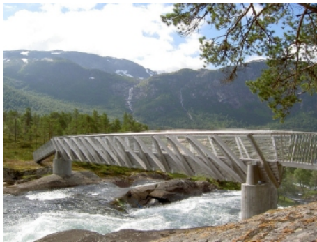
Bro över Likholeforssen byggd i LDX 2101® (Foto Pelle Johansson)
